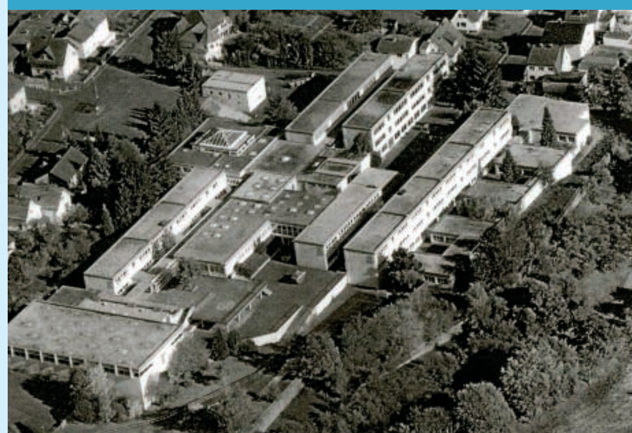
1965 wurde zwischen den Gemeinden Rodheim-Bieber, Fellingshausen, Krumbach und Vetzberg der Schulverband Biebertal gegründet. 1969 löste man die Schulen Rodheim, Bieber und Vetzberg auf und integrierte sie in die neu erbaute Mittelpunktschule. 1971 wurde die Mittelpunktschule zur Gesamtschule Biebertal unter dem neuen Schulträger (Kreis Wetzlar). 1980 wurde der Kreis Gießen aufgrund der Gebietsreform neuer Schulträger. 1989 erfolgte eine Gebäudesanierung und die Integration der Grundschule.
