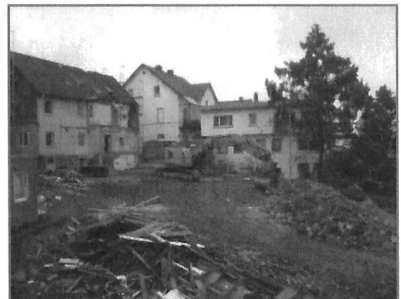
Abriss durch Fa. Kai Laumann (12.11.24)
